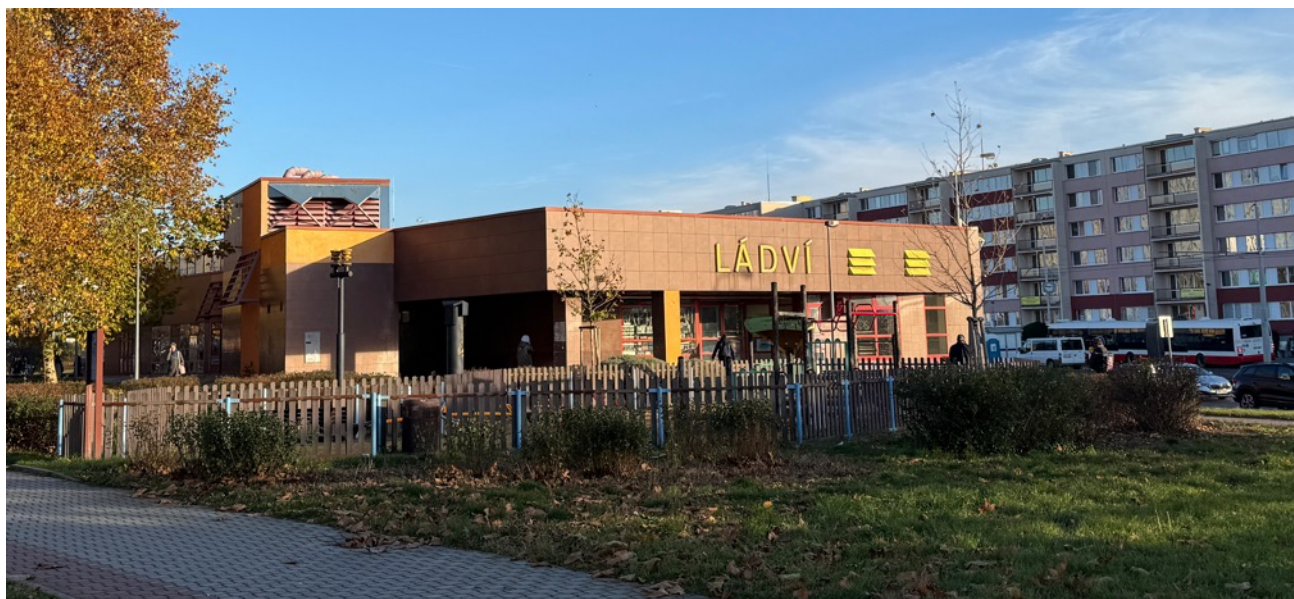
Foto č. 6,7: Plošné keřové porosty jsou udržovány tvarovacím řezem, nicméně tyto skupiny již dnes neplní dostatečně svou funkci a vzhledem k jejich postupnému rozpadu je vhodné uvažovat o jejich obnově, případně o jejich nahrazení jiným vegetačním prvkem.
