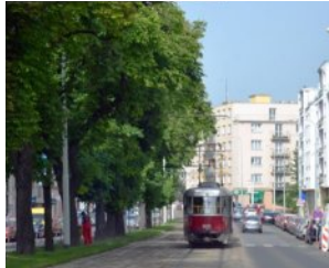
371 Trakční vedení v podobě sloupů s výložníky, které jsou umístěny v ose stromořadí [ Praha 6, Bělohorská ]
