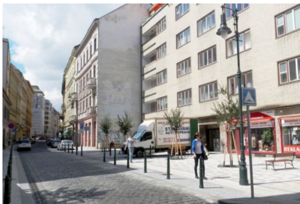
014 Častým pražským jevem jsou místa funkcionalistických činžovních domů, kde stavební čára odstupuje od uliční. Vzniká tak příležitost k obohacení ulice o drobné pobytové prostranství [ Praha 1, Soukenická ]
