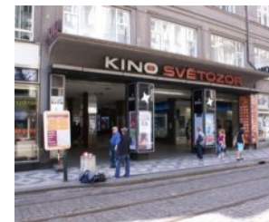
455 Ochrana před nepřízní počasí je tvořena vstupem do pasáže. Samostatný přístřešek zde není umístěn [ Praha 1, Vodičkova ]
