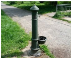
467 Tradiční pražské pítko funkčně vyhovuje. Umožňuje napouštění vody do lahve, opláchnutí rukou, případně i osvěžení zvířat. Design však odpovídá spíše historickému městu a historickým parkům [ Praha, Dobeška ]
