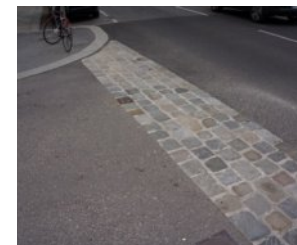
224 Vhodné materiálové odlišení zvýšeného přechodu pro chodce v křižovatce [ Rakousko, Vídeň ]
