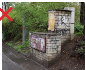
366 Nekoncepční a nezkoordinované umístování různorodých skříní technické a dopravní infrastruktury často i při snaze je sdružovat vede ke zcela neuspokojivým výsledkům [ Praha 2, Karlovo náměstí ]
