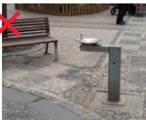
468 Pítko, které přestože je dobře přístupné pro vozíčkáře, neumožňuje napouštění vody do lahve, opláchnutí rukou, případně osvěžení zvířat [ Praha ]
