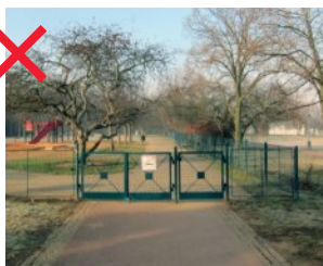
518 Neatraktivní oplocení dětského hřiště, které není součástí navazujícího prostoru a vytváří neadekvátní vymezení vůči okolnímu prostředí [ Praha 7, Letná ]
