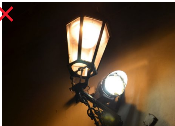
414 Nevhodná poloha a výrazné pohledové uplatnění svítidla architekturního osvětlení [ Praha 1, Zlatá ]
