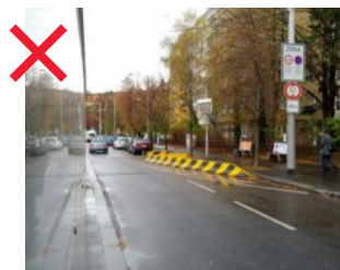
394 Citybloky – nevhodné fyzické zábrany průjezdu či parkování vozidel nebo pro ochranu chodců na přechodech. Ve městě se často vyskytují jako trvalé řešení. Dopravní vzhled neodpovídá městskému prostředí, měl by být revidován [ Praha 4, Podolí ]
