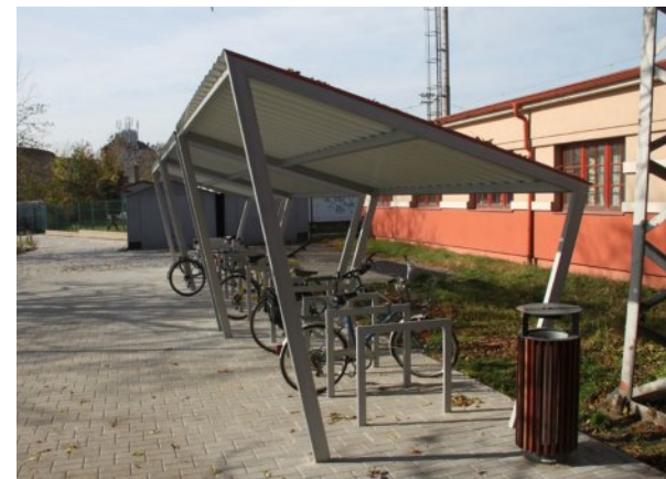
431 Zastřešené parkování jízdních kol [ Český Brod ]
