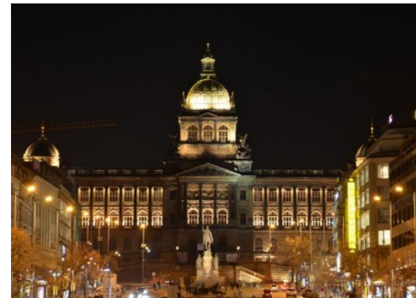
409 Vhodná kombinace plošného architekturního osvětlení a světelného zdůraznění vybraných částí budovy [ Praha 1, Václavské náměstí ]
