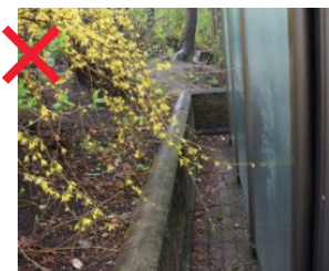
457 Přístřešek by neměl vytvářet špatně udržovatelná zákoutí [ Praha 2, Karlovo náměstí ]
