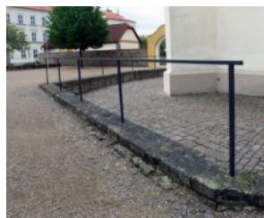
490 Vhodný příklad subtilního zábradlí jednotné barevnosti a umírněného designu [ Litomyšl, Zámecká ]
