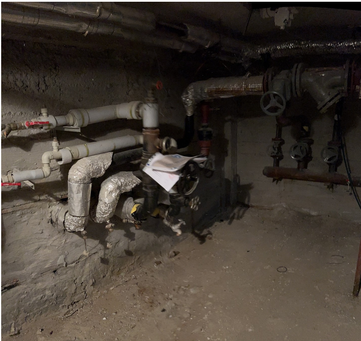
Obrázek 8 technologické rozvody vody, TUV
