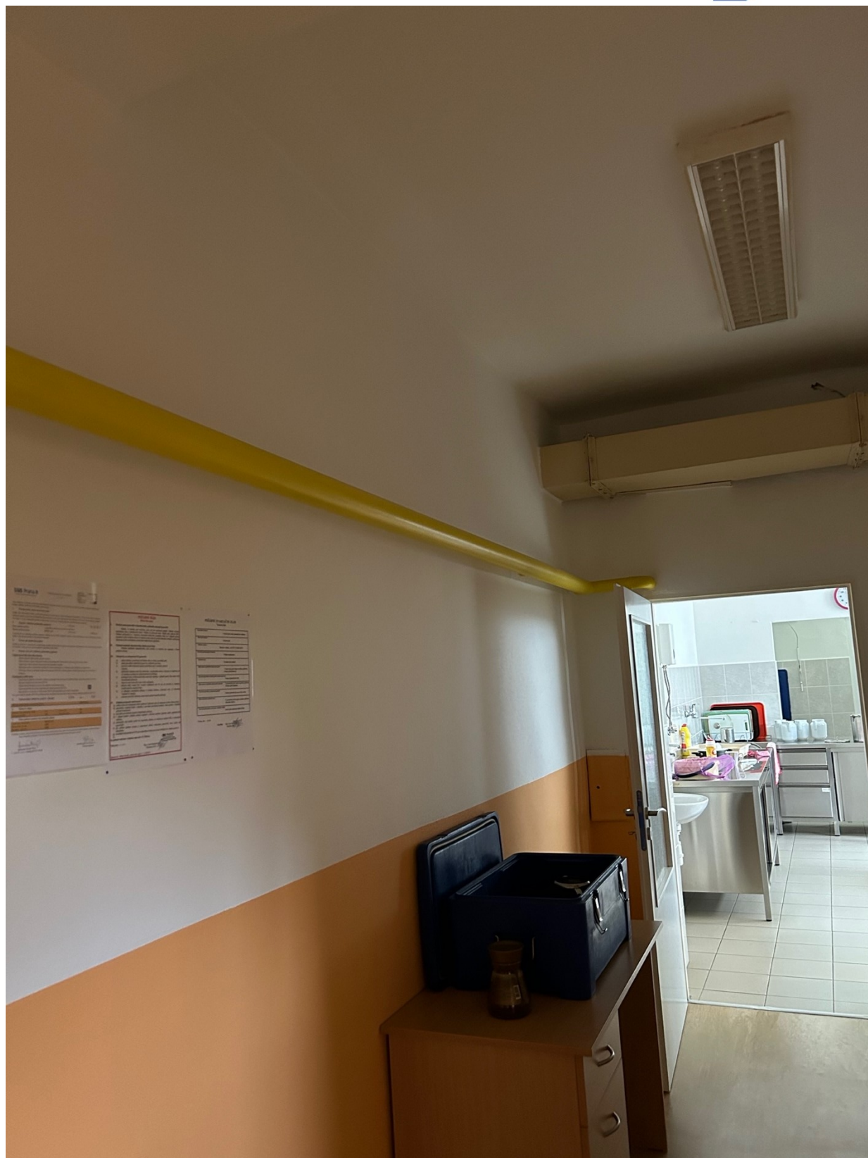
Obrázek 14 1.NP rozvod plynu
