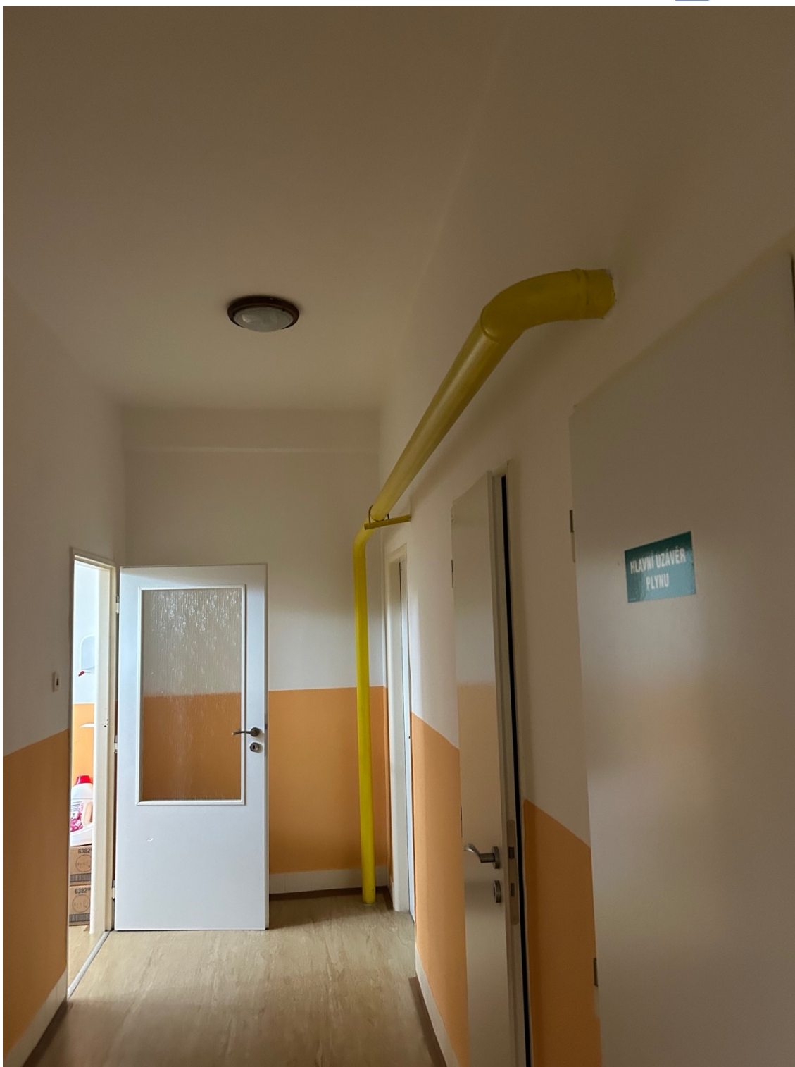
Obrázek 13 1.NP rozvod plynu
