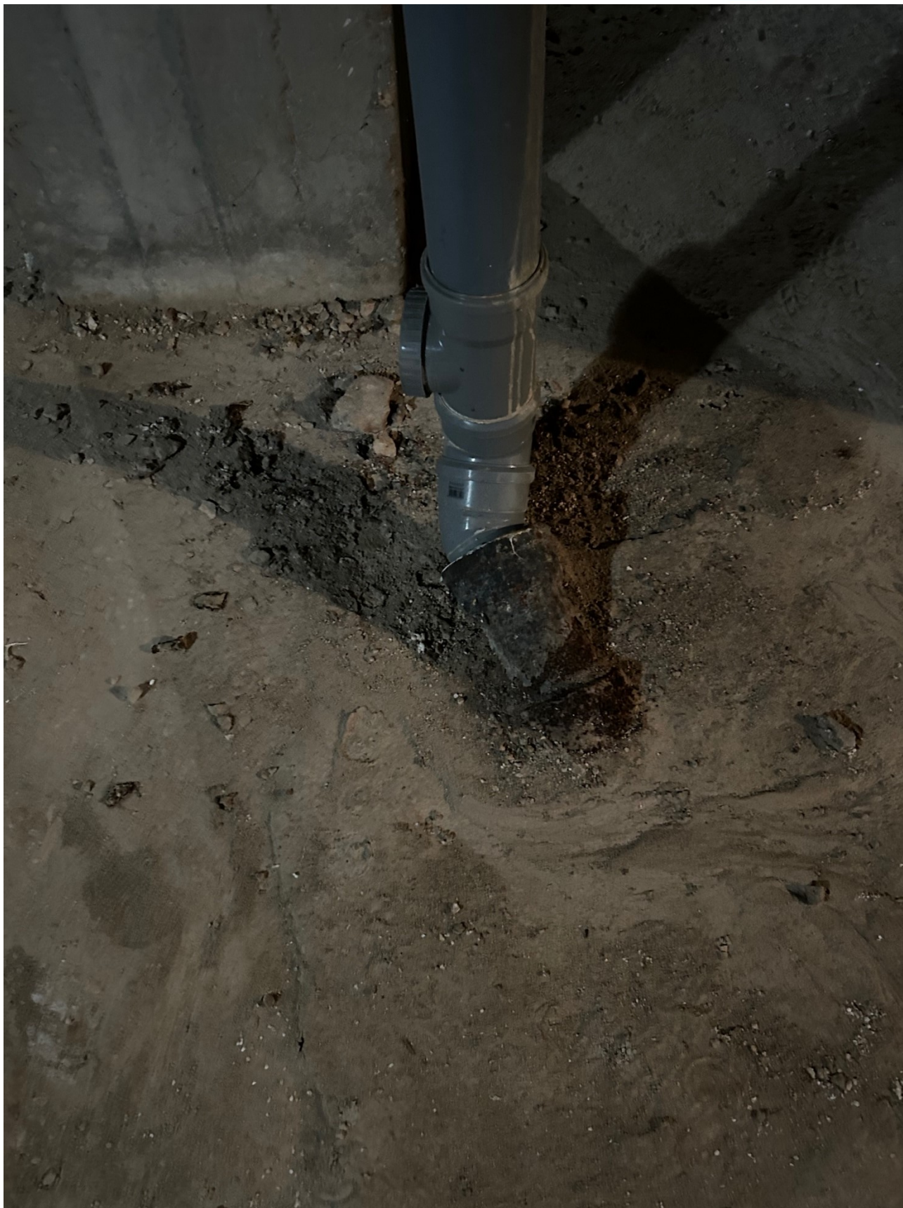
Obrázek 2 suterén napojení kanalizace
