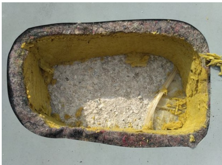
Obrázek 16 sonda do ploché střechy
