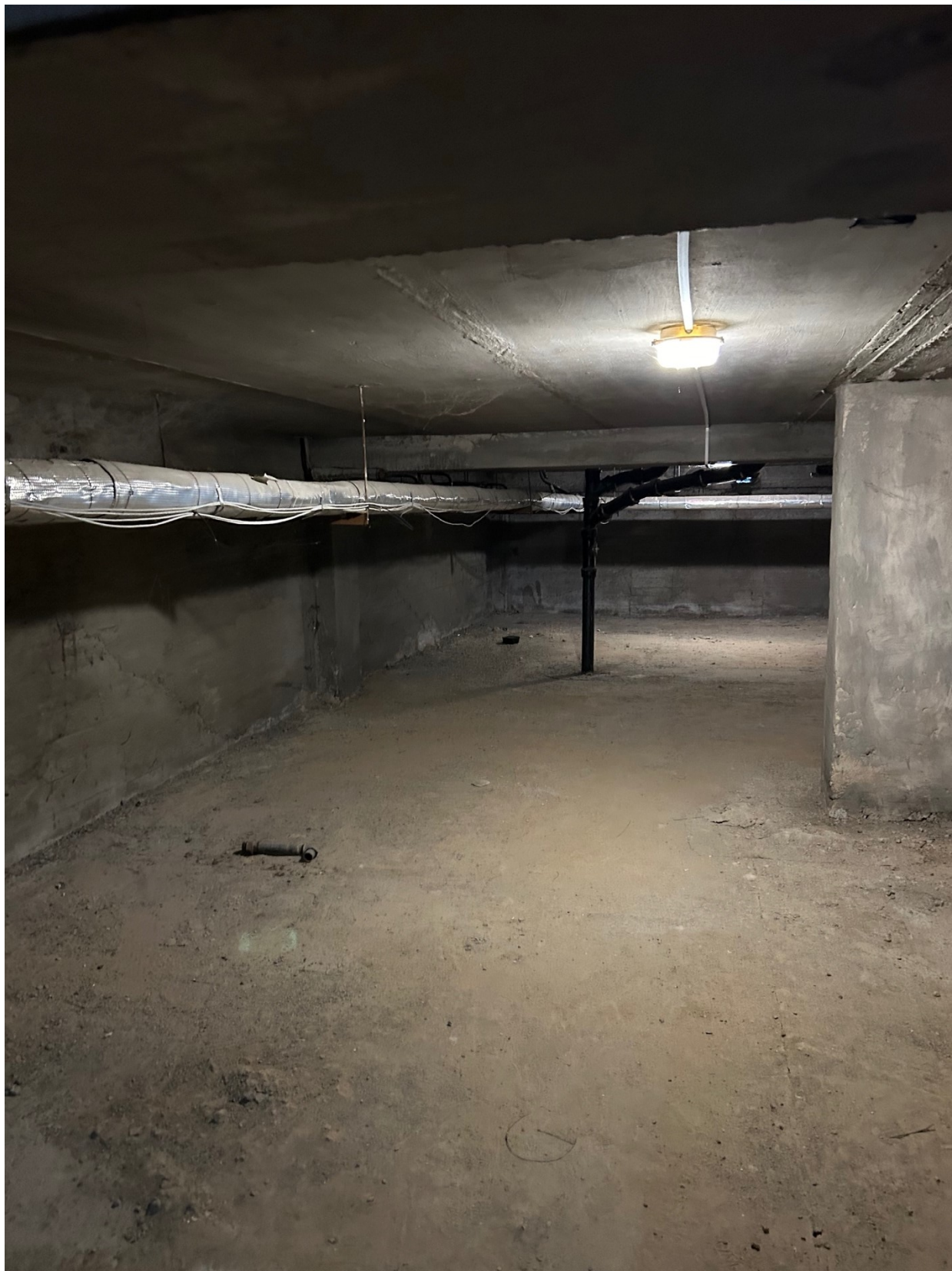
Obrázek 4 suterén rozvody topné soustavy
